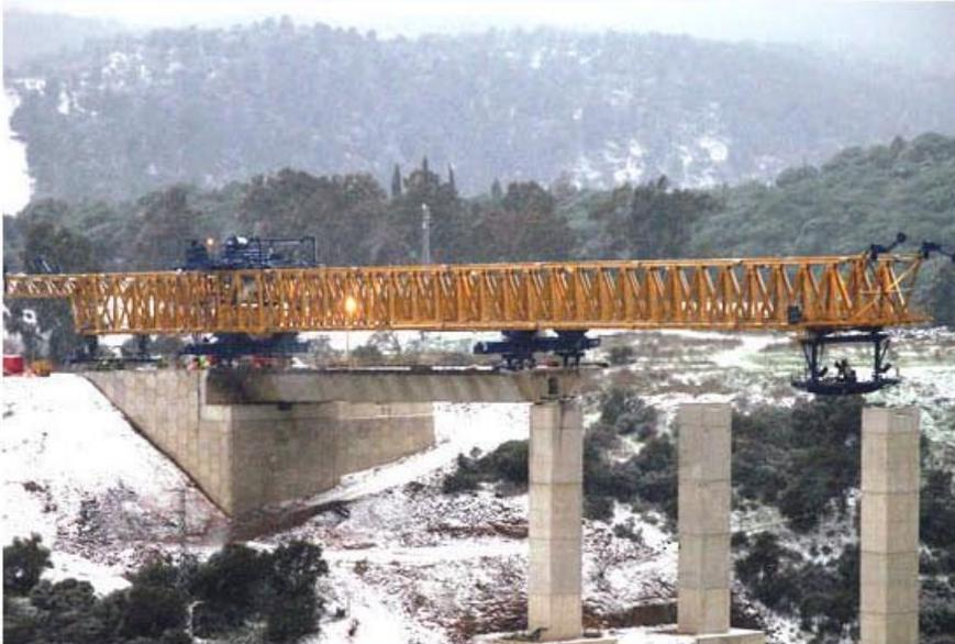
Cimbra autolanzable de dovelas prefabricadas en el vano 1 del Viaducto de Despeñaperros. A-4.
