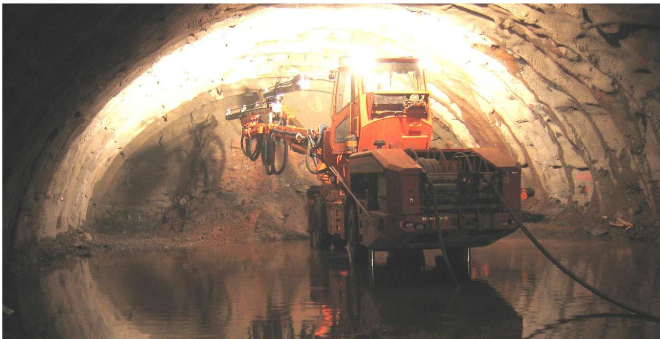
Perforación en avance del túnel de Despeñaperros con Jumbo.
